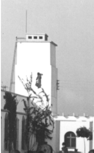
La torre-depósito de agua.
