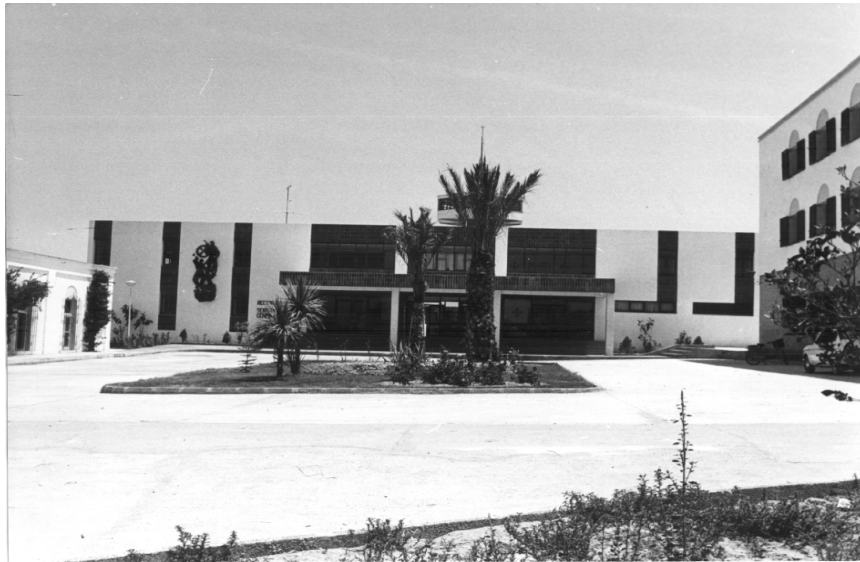
Edificio de Servicios Generales, con las dos residencias en los laterales.
